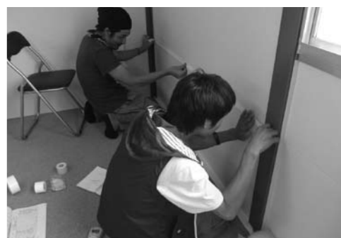
壁のパネルにある凹みに断熱テープを張ることで断熱性能を高めるとともに、結露対策にもなっている
