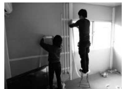
作業の様子（集会所でのモデル改修）
